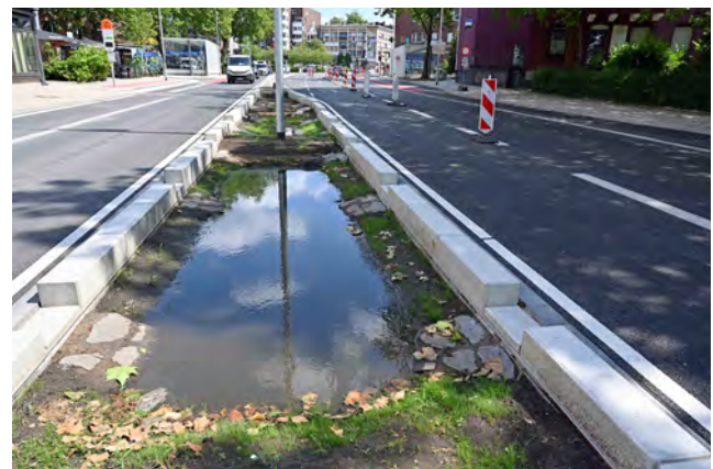
Abbildung 3-2 Begrünte Regenwasserrigole in der Hattinger Straße in Bochum nach Tieflegung der Straßenbahn; links vor und rechts nach Umsetzung (Quelle: Stadt Bochum, Pressestelle)
