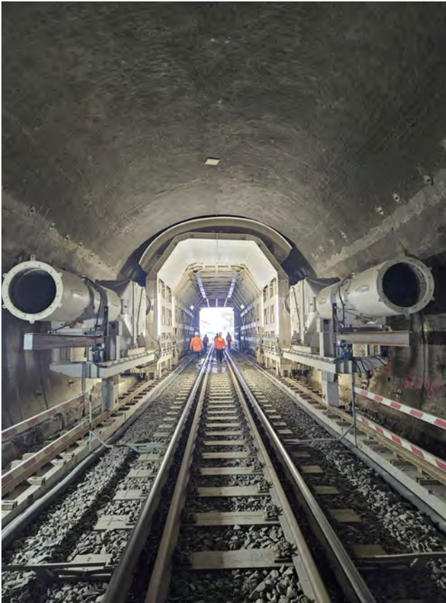
Abbildung 4-5 Erneuerung Fachinger Tunnel: Innenansicht Bestandstunnel mit Tunnelaufweitungssystem (links) und Ansicht Portal (rechts); (Quelle: Porr)
